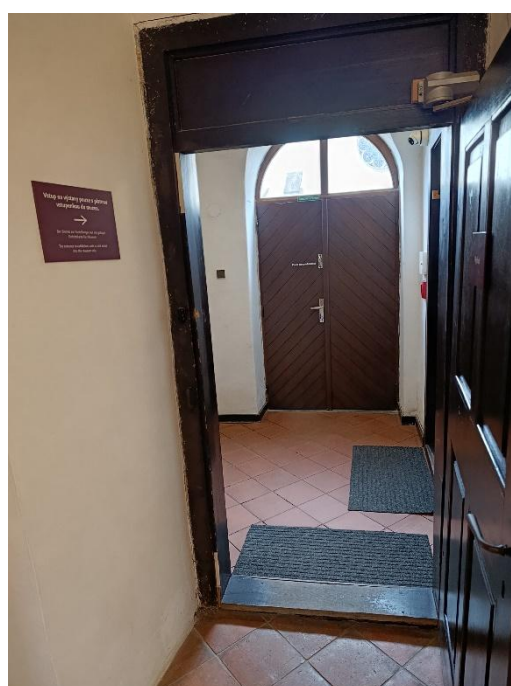
Foto 7: Výstavní prostory vstup přízemí - vstup na chodbu
